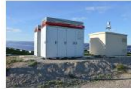
Exemple type d'onduleur outdoor (source : QUADRAN)
